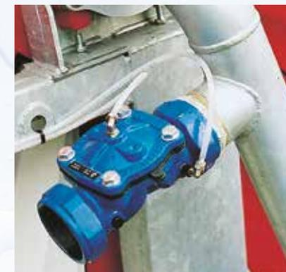
Valvola di scarico idropilotata
