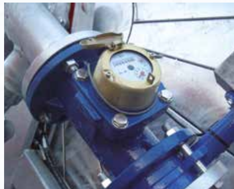
Litromierz z połączeniem kołnierzowym na wejściu bębna.
