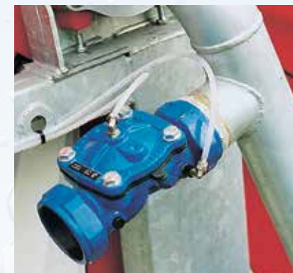
Vanne de pression hydro-pilotée
