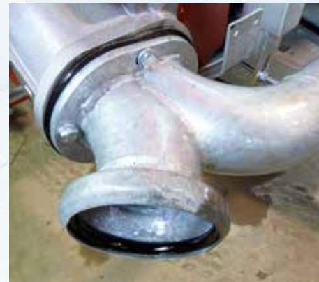
Intrare apă pe ambele laturi. (standard pe toate modelele Gx începând cu 581).
