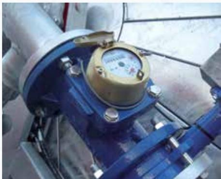
Счетчик фланцевый на входе катушки
