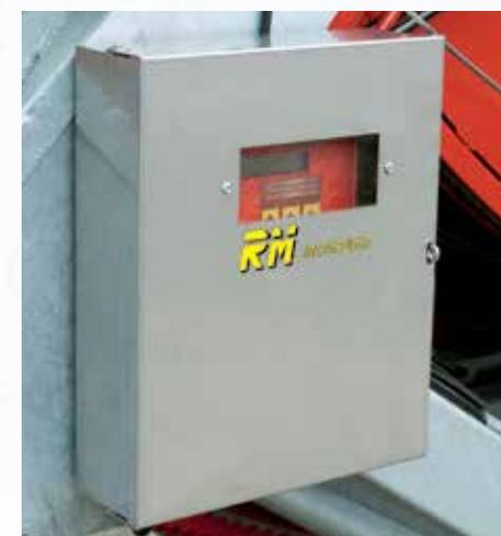
Защитная коробка из нержавеющей стали для программатора RainMaster 2.6.
